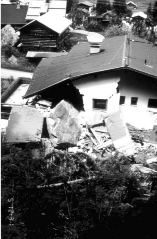
Abbildung 06: See im Paznaun: Großblock mit ca. 30 \text{ m}^3 beschädigt ein Wohnhaus so stark, dass es nicht mehr bewohnbar ist.
